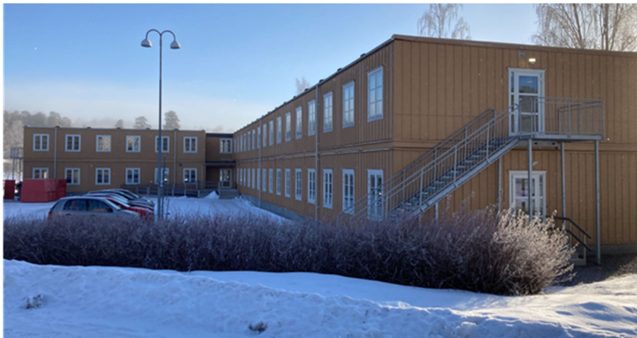
Figur 8 Tillfälliga moduler Campus Falun (även kallat språkhuset). Foto: Ola Staffansson
